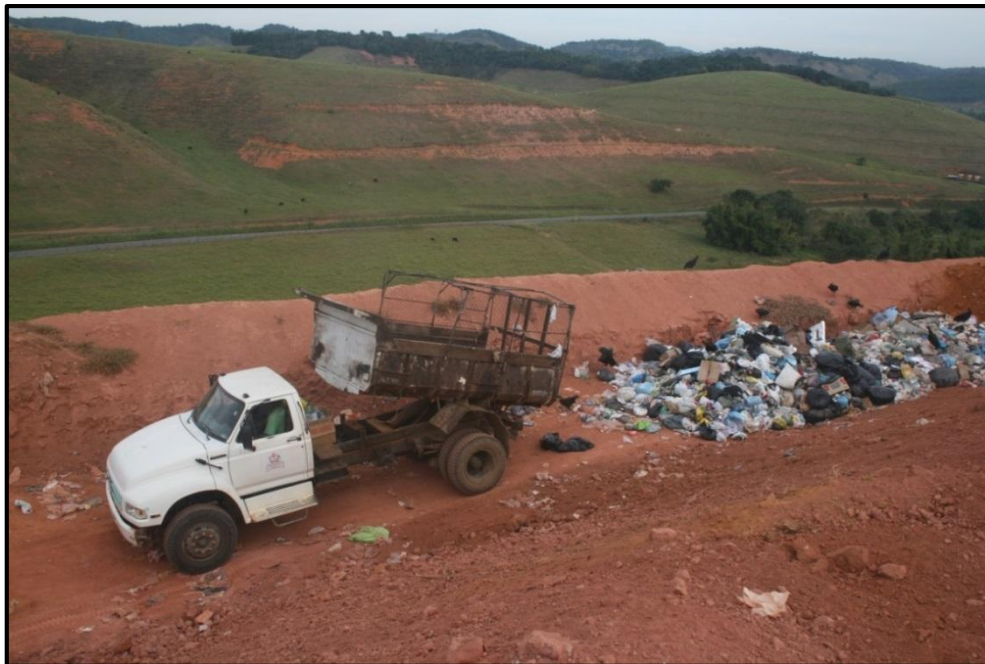
Figura 63 – Caminhão basculando o lixo domiciliar em valas no aterro controlado
