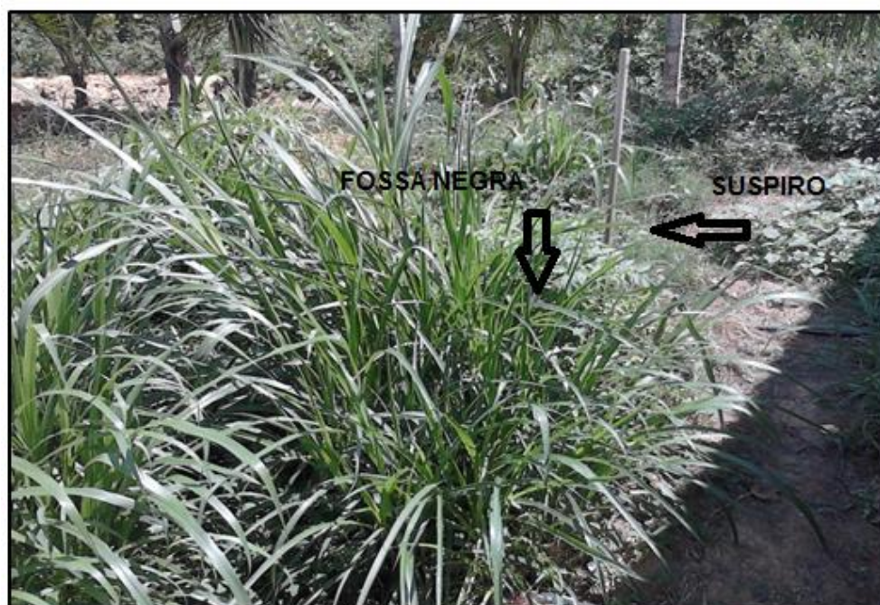
Figura 54 - Fossa Negra de residência da comunidade de Ferreiras
