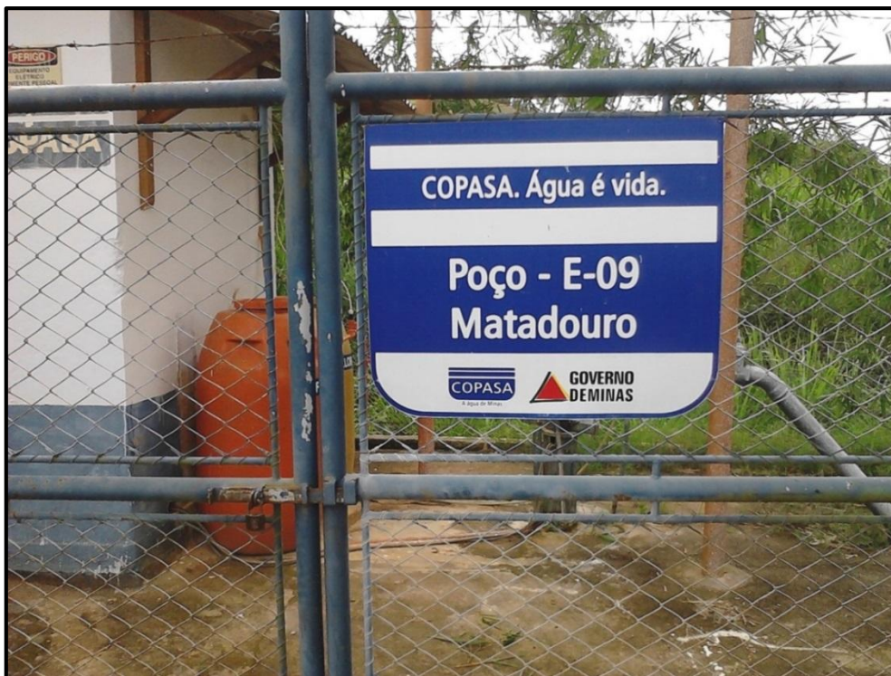
Figura 34- Poço E-09 (Matadouro) que abastece o RAP02-RAP03-RAP04, abastecendo os bairros João Gonçalves da Neiva e Sossego
