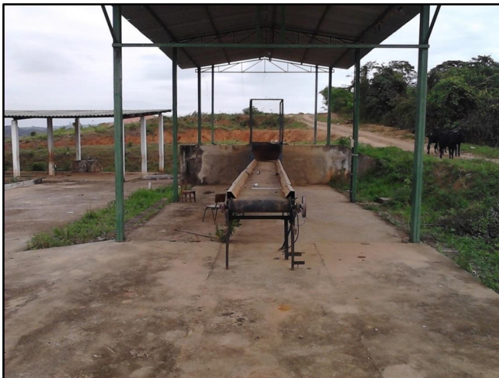
Figura 60 – Esteira destinada para transportar fados prensados.
