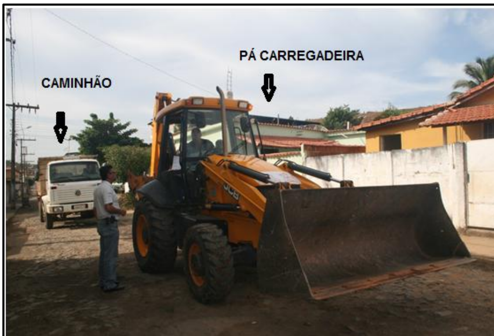
Figura 69 – Comboio destinado a recolher os entulhos e resto de construção civil.
