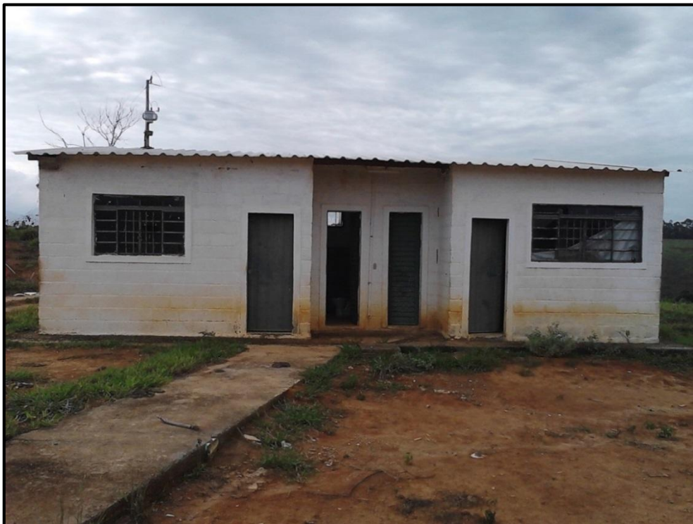
Figura 62 – Vestiários e banheiros feminino e masculino.
