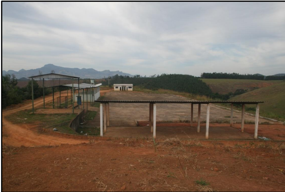
Figura 57 – Usina de triagem e compostagem, desativada.
