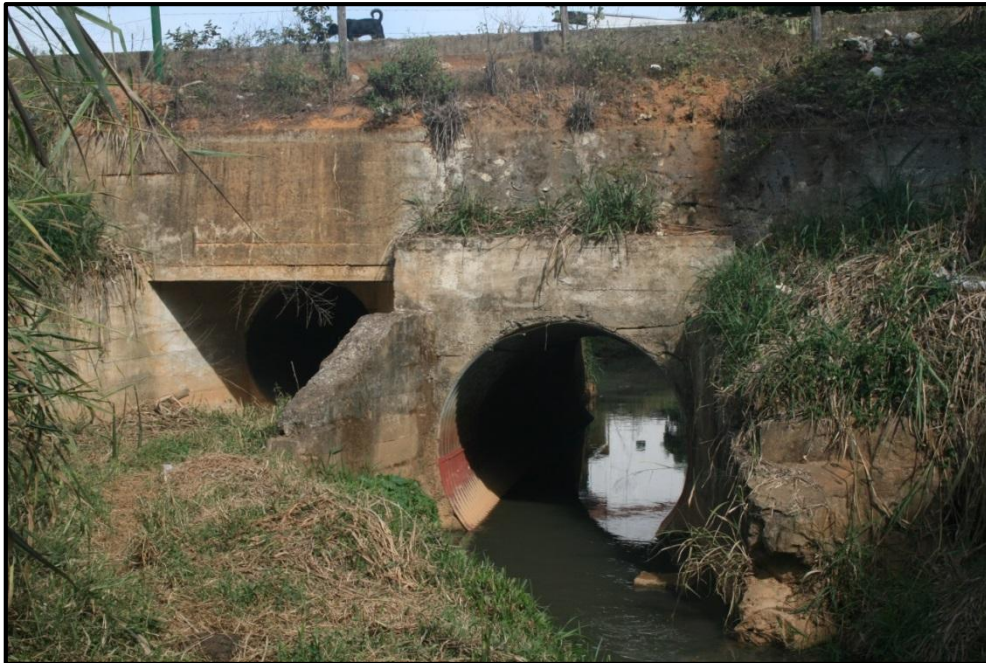
Figura 76 – Obra executada posterior ao alagamento de 2002 com duas tubulações paralelas para melhor escoamento das águas.
