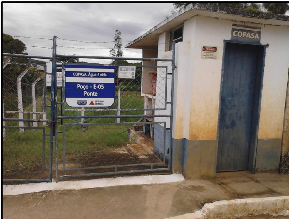
Figura 33 - Poço E-05 (Ponte) que abastece o Bairro Piraubinha e Santa Terezinha
