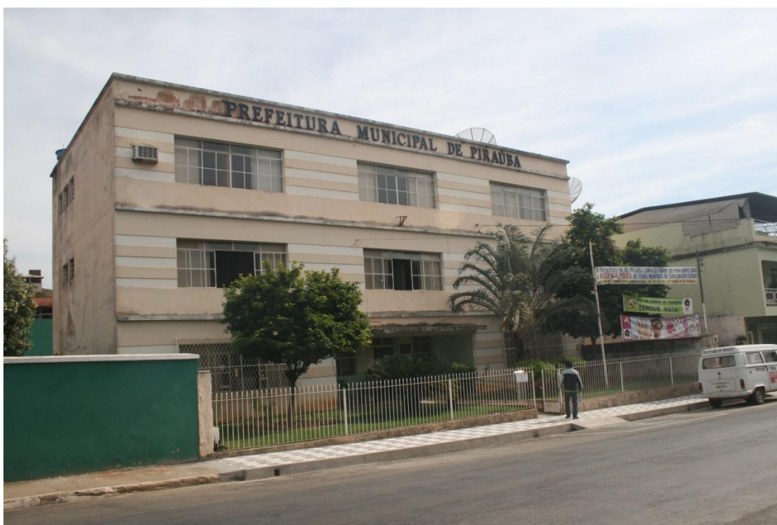
Figura 21 - Sede da Prefeitura Municipal de Piraúba, na Rua Opemá Nº 610 - Centro
