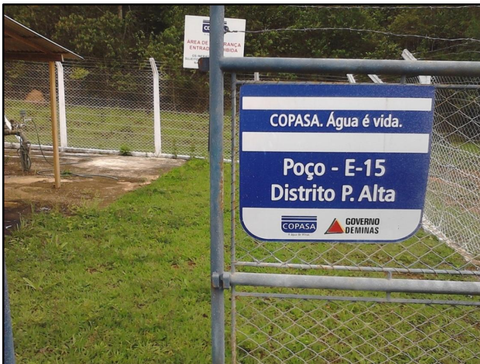
Figura 38 - Poço E-15 (Distrito P. Alta) que abastece o Bairro João Gonçalves da Neiva
