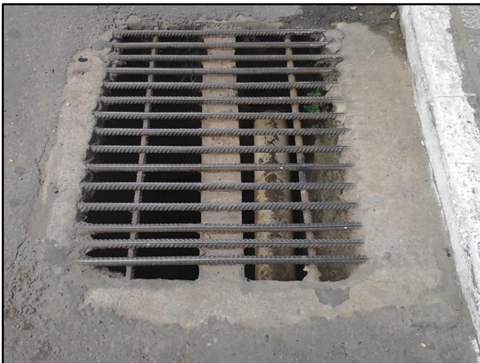
Figura 74 – Detalhe do tipo de boca de lobo.
