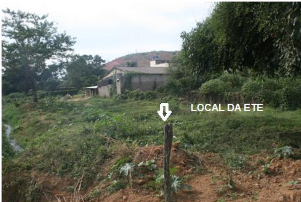
Figura 45- ETE matadouro totalmente coberta por vegetação encontra-se saturadas e abandonadas
