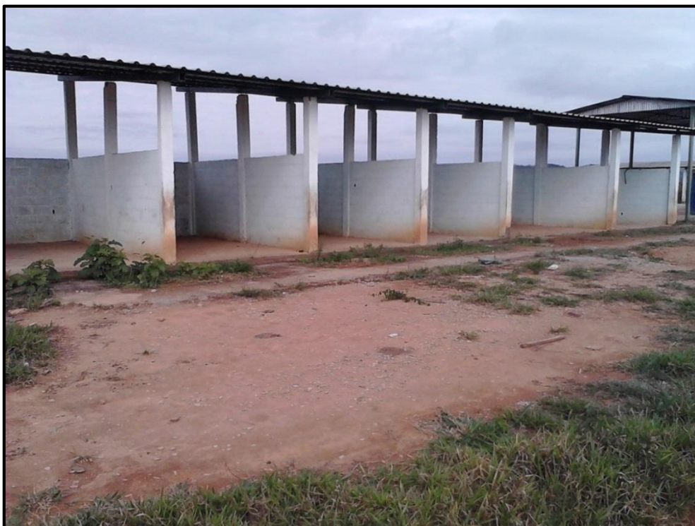
Figura 58 – Baias para armazenamentos e triagem de resíduos sólidos prensados
