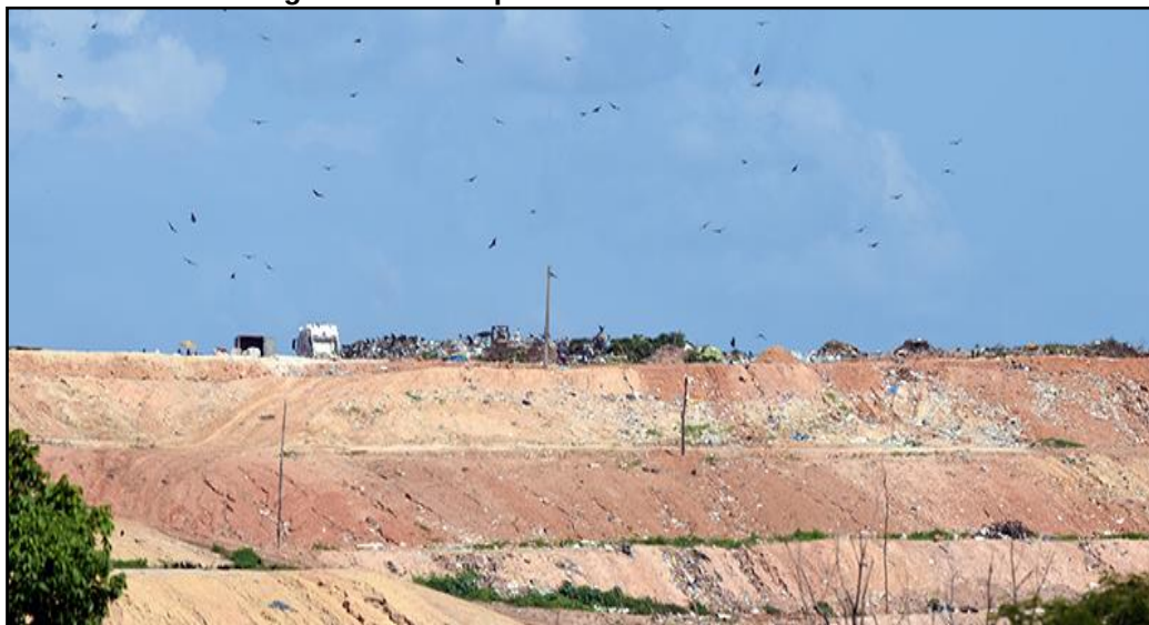
Figura 56 - Exemplo de aterro controlado.
