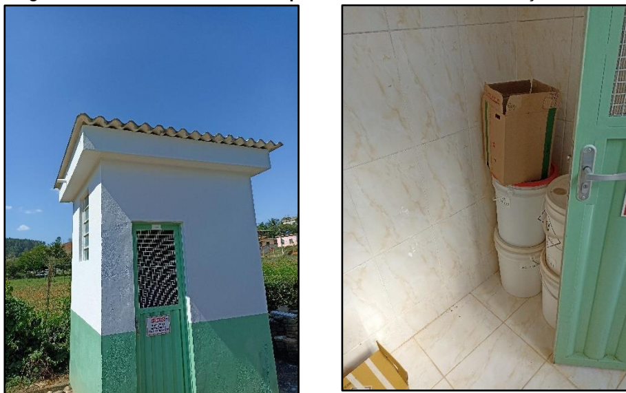
Figura 43 - Acondicionamento adequado de RSS no PF João Gonçalves da Neiva.
