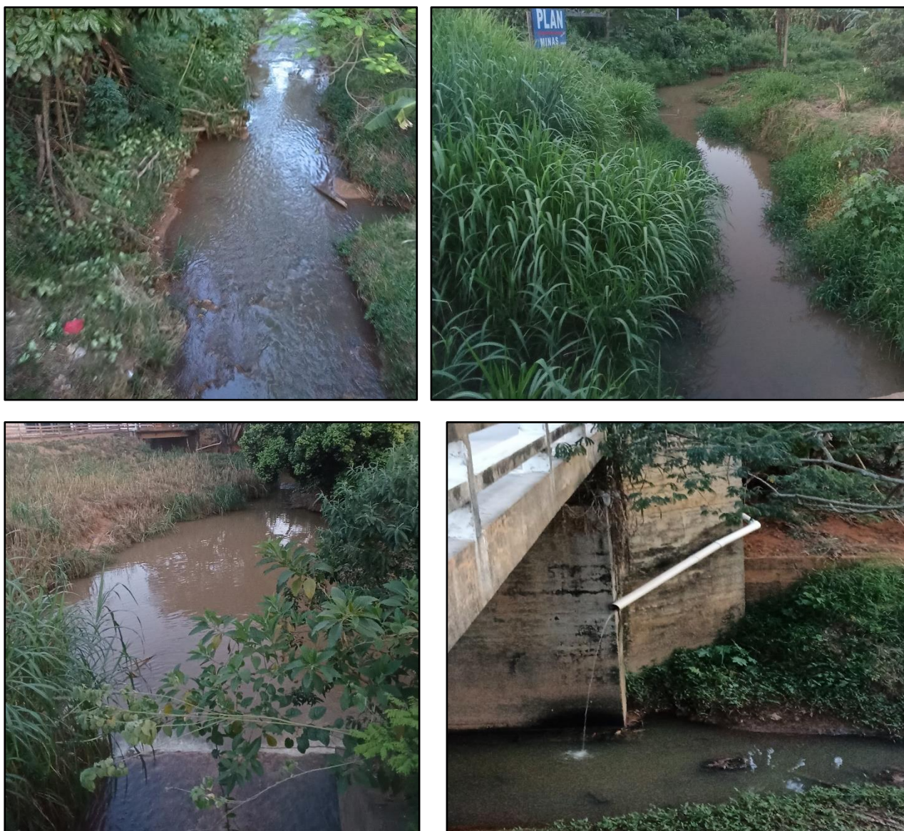
Figura 26 - Disposição de esgotos domésticos diretamente no rio.
