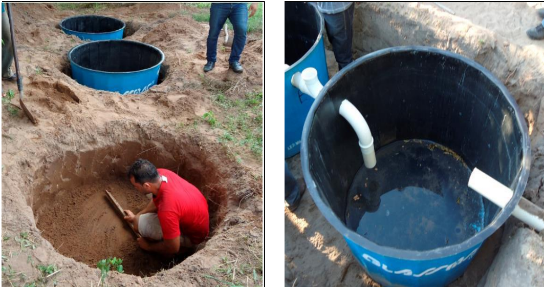
Figura 81 - Exemplo de instalação da fossa biodigestor.
