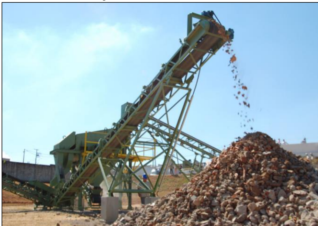
Figura 107 - Usina fixa de RCC.
