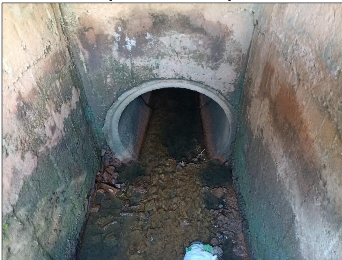
Figura 58 - Obras na macrodrenagem.
