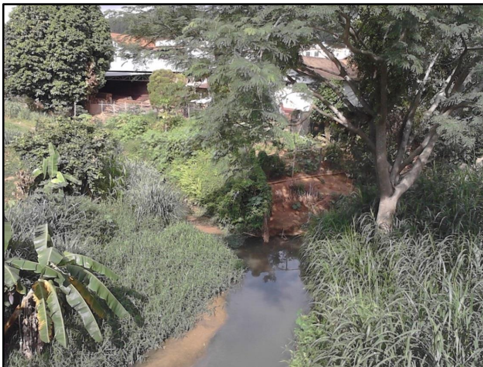
Figura 79 – Margens necessitando um tratamento adequado.
