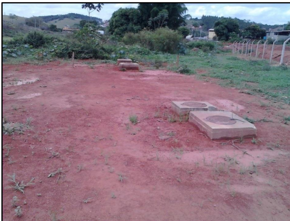
Figura 51 - ETE do distrito industrial, enterrada do tipo fossa séptica coletiva seguida de filtro anaeróbico, necessitando uma melhor manutenção.
