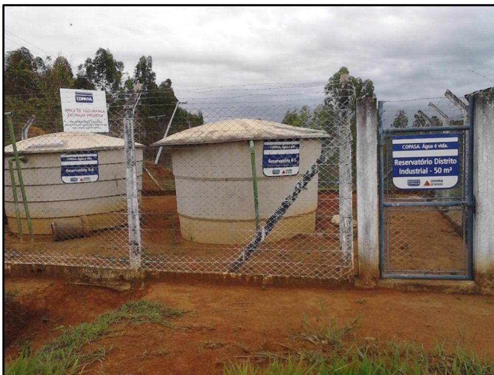
Figura 41 - Reservatórios RAP-05 / RAP-06 / RAP-07 – Apoiado com capacidade: 50 m³ (Abastece os bairros João Gonçalves Neiva e Distrito Industrial/Parte Alta)
