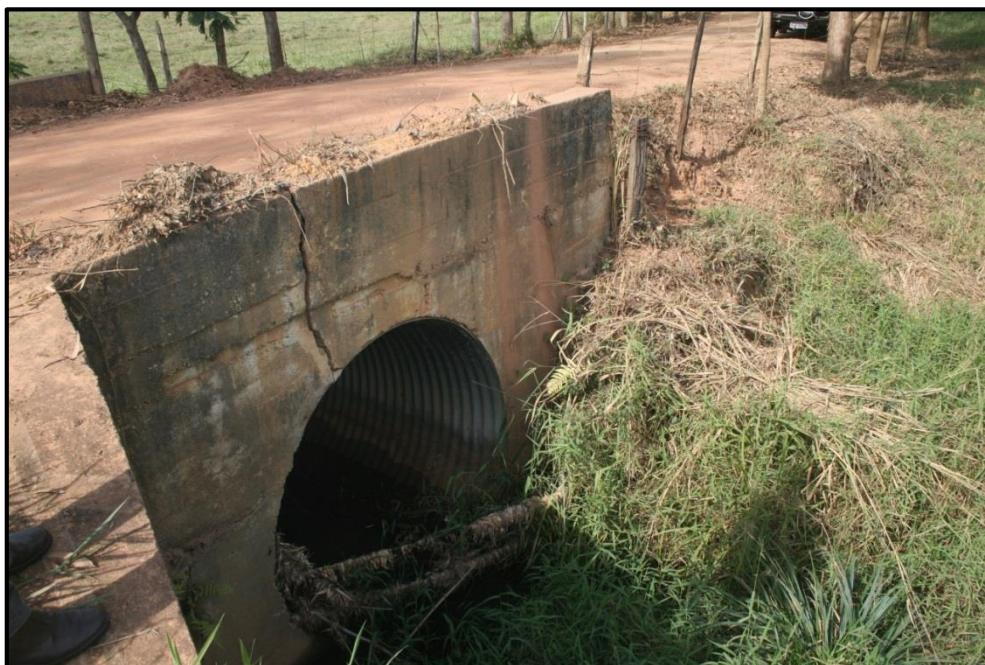
Figura 77 – Galeria que foi modificada no bairro da Granja para eliminar ocorrência de enchentes.
