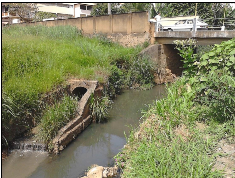
Figura 78 – Esgoto domestico sem tratamento sendo lançado no ribeirão Piraúba.
