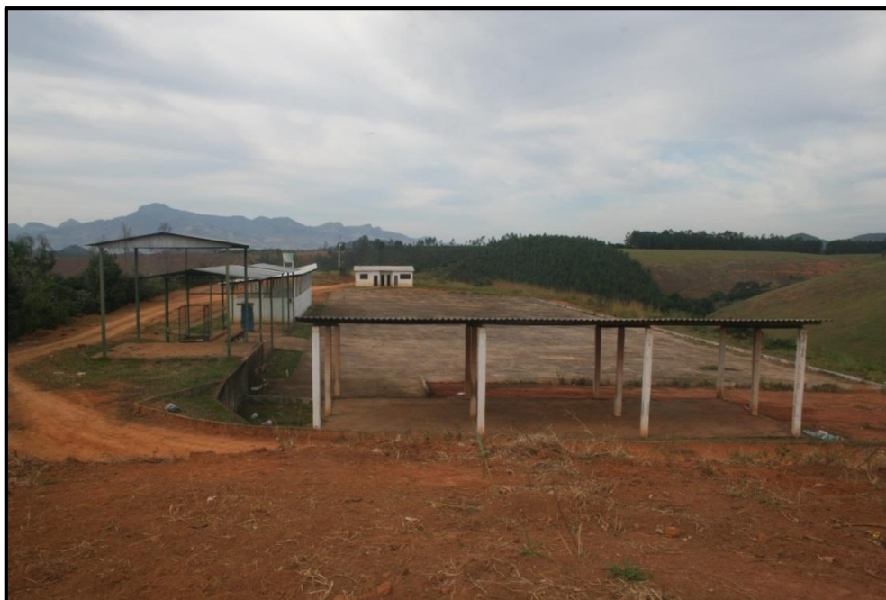
Figura 57 – Usina de triagem e compostagem, desativada.
