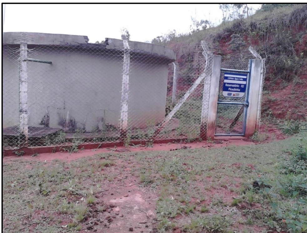
Figura 40 - Reservatório RAP- 08 – Apoiado de concreto com capacidade: 150 m³ (Abastece os bairros Piraubinha e Santa Terezinha)
