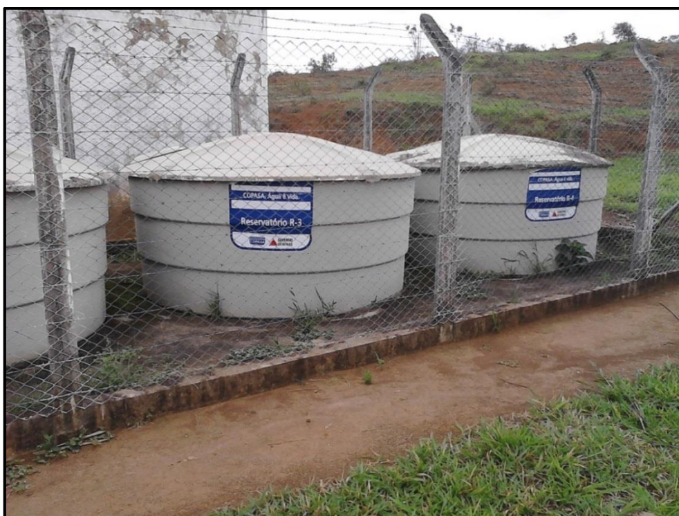
Figura 42 - Reservatórios RAP-02 / RAP-03 / RAP-04 – Apoiado com capacidade: 45 m³ (Abastece os bairros João Gonçalves da Neiva e Sossego)
