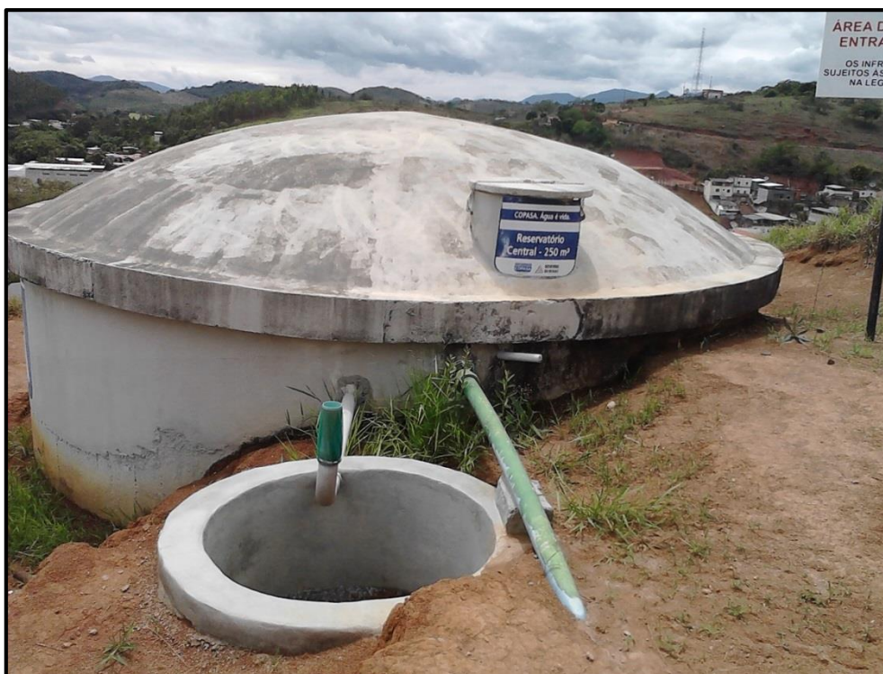
Figura 39 - Reservatório Central RAP-01, de concreto apoiado com capacidade: 250 m³
