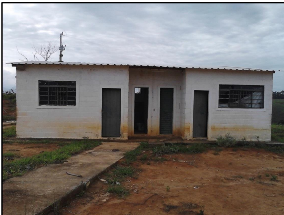
Figura 62 – Vestiários e banheiros feminino e masculino.
