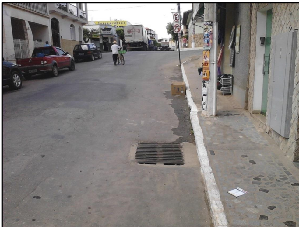
Figura 73 – Boca de lobo com barras de ferro
