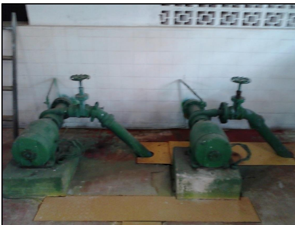
Figura 32 - Bombas centrífugas responsáveis por recalcar a água tratada do tanque de contato para a cidade.
