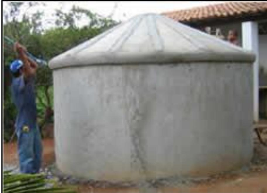
**Figura 13 - Cisterna com custo reduzido de ferro-cimento.**
