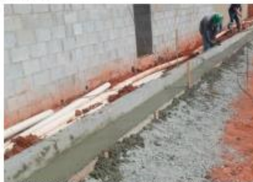
Exemplo de execução de sarjeta moldada in-loco
