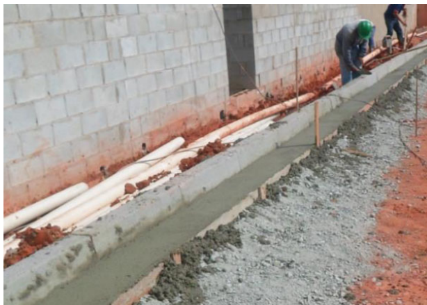
Exemplo de execução de sarjeta moldada in-loco
