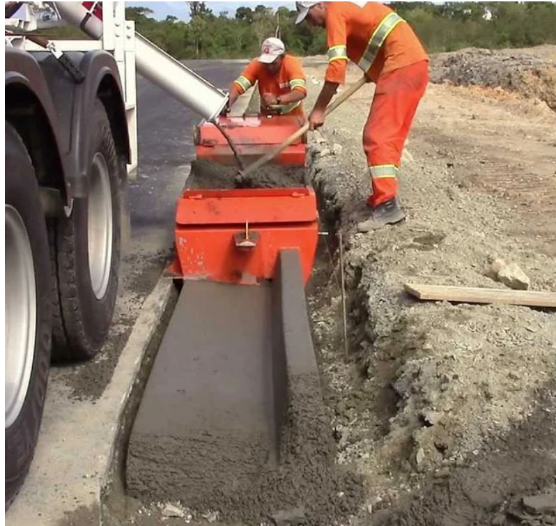
FIGURA 3: Exemplo de execução de guia e sarjeta com máquina extrusora
